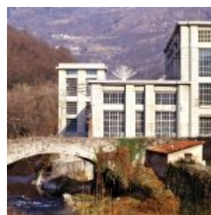
Centrale di Cedegolo – ERIH Anchor Point
